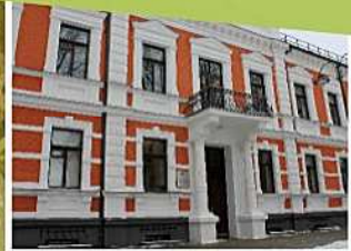
Реконструкция здания полиции самоуправления г. Даугавпилса. 2008 год. Заказчик: Даугавпилсская городская дума
